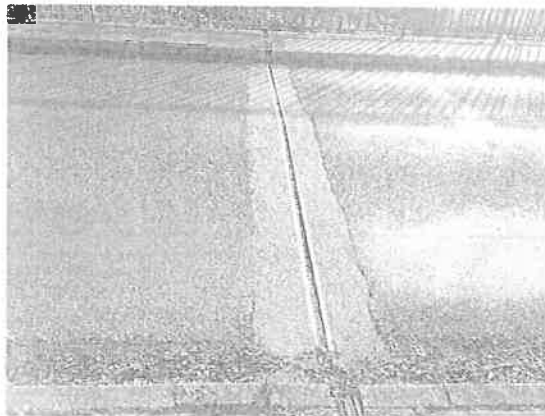
Joint de chaussée
